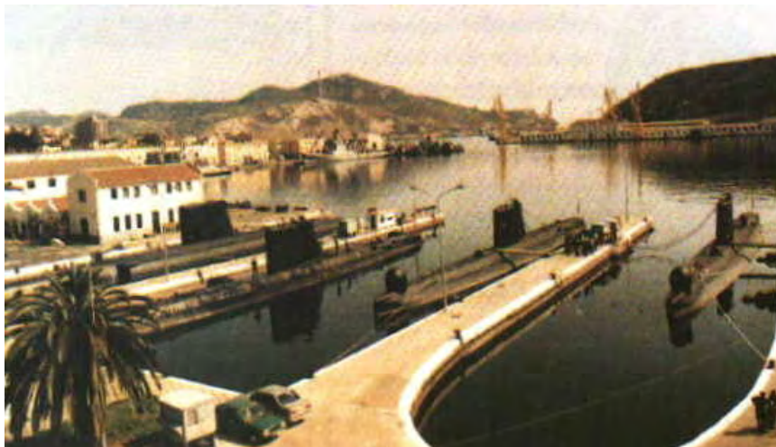
Figura 8 PRIMERA FASE DE LA REMODELACIÓN Y DESTRUCCIÓN DE LOS DIQUES DE FERINGÁN PARA LA CREACIÓN DE LA BASE DE SUBMARINOS DE CARTAGENA
