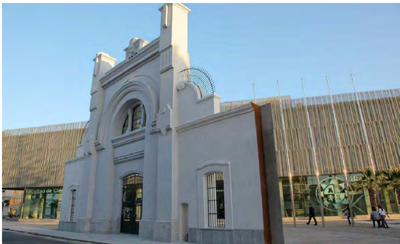
Figura 19 ESTADO ACTUAL DE LA PORTADA DEL ANTIGUO CUARTEL DE INSTRUCCIÓN DE MARINERÍA, INTEGRADA EN LA ACTUAL FACULTAD DE ECONOMÍA Y EMPRESA DE LA UNIVERSIDAD POLITÉCNICA DE CARTAGENA
