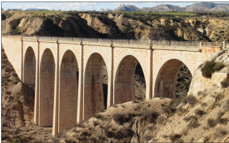
Infraestructura construida para salvar la Rambla de Perea; hoy forma parte de la Vía Verde del Noroeste, magnífico mirador para observar el paisaje. Fotografía: G. Canales Martínez.
