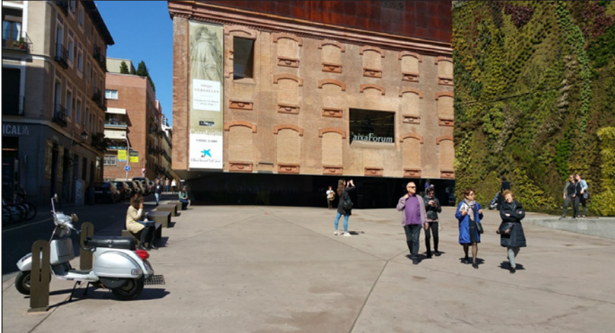
Figura 4 ESPACIO PÚBLICO GENERADO TRAS LA REHABILITACIÓN DE LA ANTIGUA ESTACIÓN ELÉCTRICA DEL MEDIODÍA
