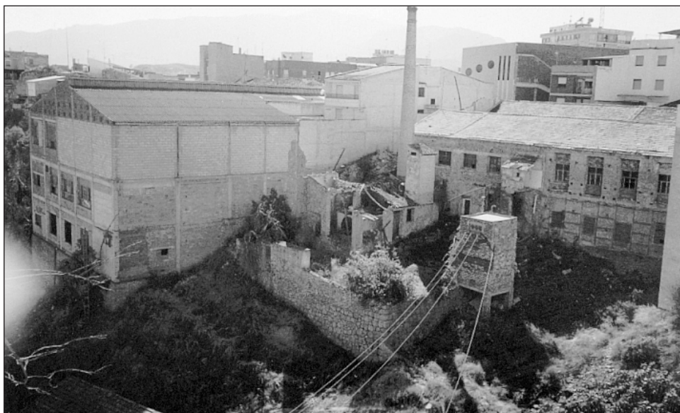
Foto 2: Restos de un edificio industrial en el centro de Abarán.
