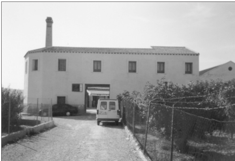
Foto 4: Conjunto de instalaciones fabriles rehabilitadas en Ceutí.
