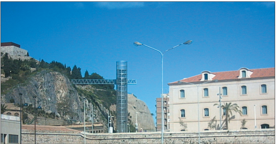
IMAGEN 4: Ascensor panorámico con acceso al Centro de Interpretación del Castillo de la Concepción de Cartagena, ejemplo de las infraestructuras realizadas con FEDER.
