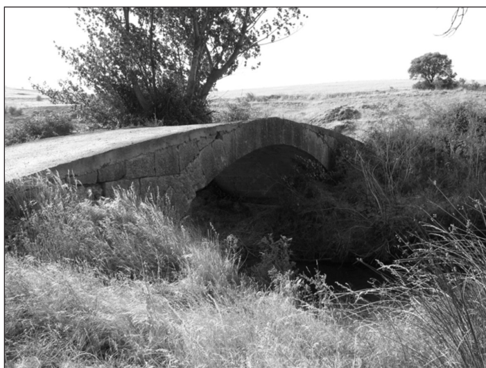
Figura 3 PUENTE DE LA ALMADA (VILLAREAL DE HUERVA)
