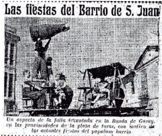
Imagen 8. Falla avenida Ronda de Garay. Murcia, 1947. Fuente: Hoja del Lunes . 23/6/1947. AMM.
