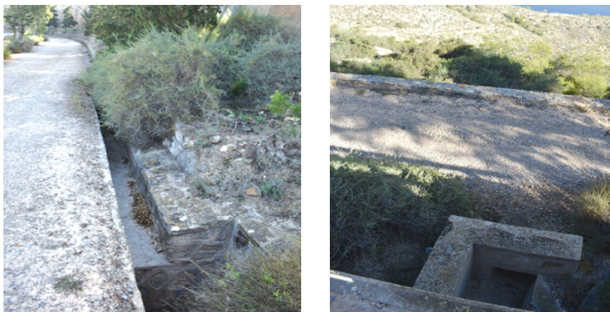
Figura 18. Canalización al borde de la carretera de acceso y paso inferior hasta la ladera. Fuente: autor.
