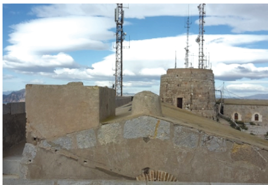
Figura 4. Depósito de aguas pluviales en el techo a dos aguas, Castillo de San Julián. Fuente: autor.
