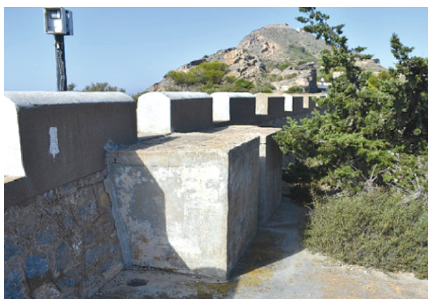
Figura 13. Depósitos para la recogida de aguas pluviales, conectados por una tubería y situados al final de una leve pendiente. Fuente: autor.
