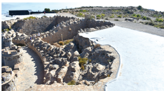
Figura 16. Explanada de los cañones de Castellitos, inclinada para alimentar el aljibe (situado en el centro de la fotografía). Fuente: autor.
