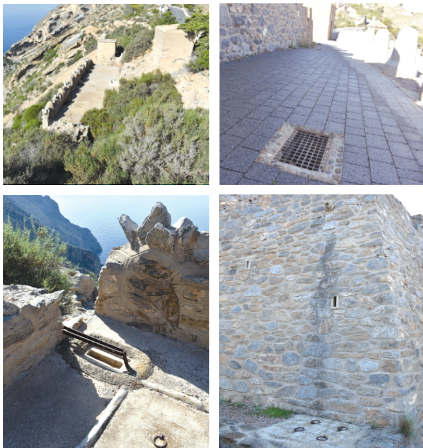
Figura 14. Composición del sistema de alimentación del aljibe: explanada donde se sitúa el aljibe (arriba izq.), sumideros para infiltración a galerías subterráneas (arriba dcha.), bombas de extracción de agua del aljibe (abajo izq.) y gárgola en Castillitos (abajo dcha.). Fuente: autor.
