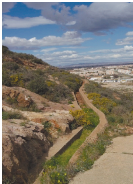
Figura 11. Canal para la captación de la escorrentía en el cerro de la Atalaya. Fuente: autor.
