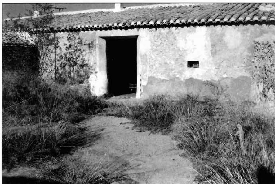
FOTO 2: Patio y acceso antiguo a la almazara (32 y 33).
