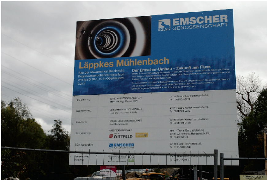
Abbildung 3. Bauplatkat beim Umbau der Abwasserkanäle an der Emscher. Quelle: Autorin.
