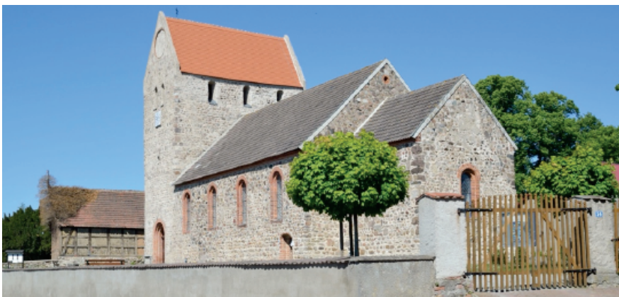
Figura 5. Iglesia construida con «piedra de campo» en Altensalzwedel, región de Altmark (foto: Hansjörg Küster).
