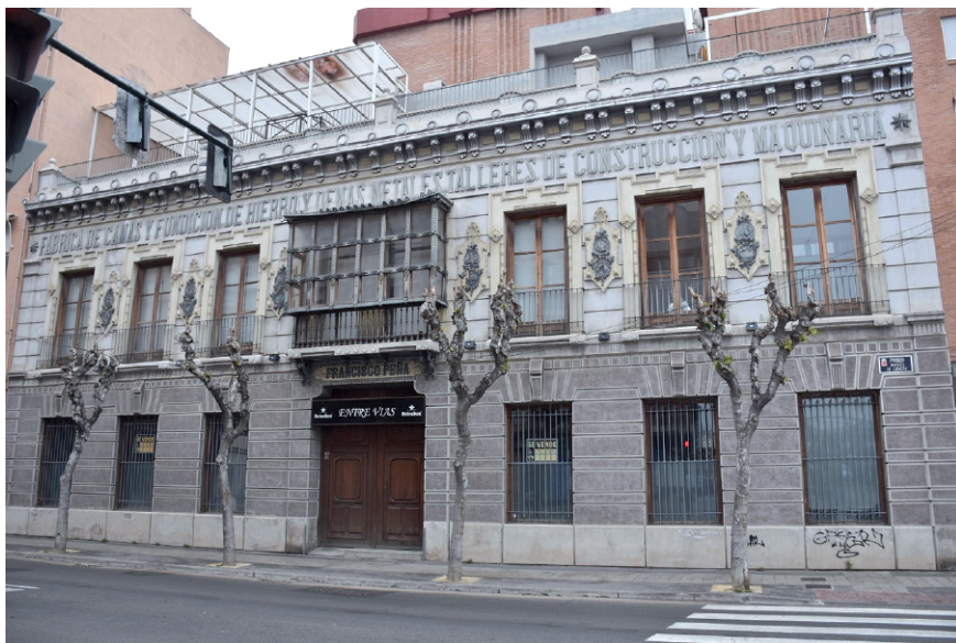
Imagen 1. Edificio conservado de la Fundición Peña en la ciudad de Murcia, Paseo marqués de Corvera. Autora: Palazón.
