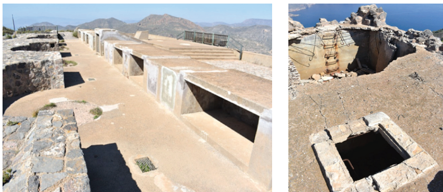
Figuras 21 y 22. Sumideros que infiltran el agua en la galería, parte superior de la batería del Atalayón. Fuente: autor. Vista superior de los depósitos, batería del Atalayón. Fuente: autor.
