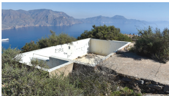
Figura 17. Balsa con pequeño aclarador en la Batería de Castellitos. Fuente: autor.
