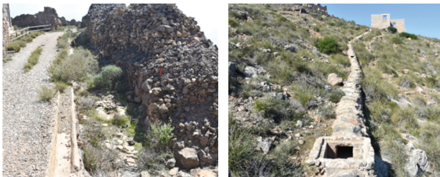
Figura 24. Canalizaciones de aguas abiertas hacia el aljibe (izq.) y cubiertas, con arquetas, de salida para otros destinos. Fuente: autor.
