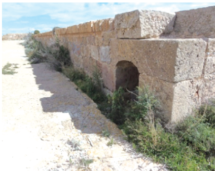
Figura 9. Canalizaciones en el piso superior del castillo de la Atalaya y arcada para su caída y conducción al piso inferior. Fuente: autor.
