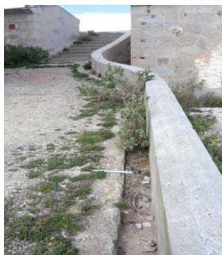
Figura 5. Canalización para recogida de pluviales paralela a la rampa y escalera, Castillo de San Julián. Fuente: autor.
