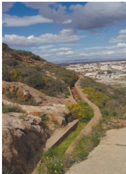
Figura 11. Canal para la captación de la escorrentía en el cerro de la Atalaya. Fuente: autor.
