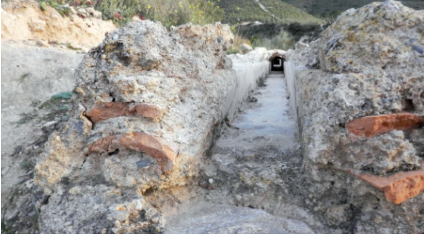
Figura 5. Caño del Barracón. Detalle de la estructura y perspectiva de la canalización.
