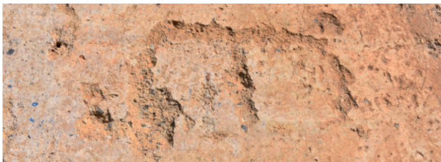
Figura 10. Muro de la Torre de Inchola donde se aprecia un motivo con forma de omega.
