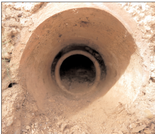
Figura 9. Vista en detalle de los atanores.
