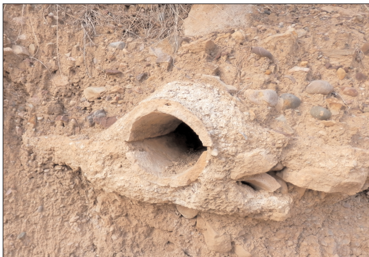
Figura 10. Conducción de doble teja.
