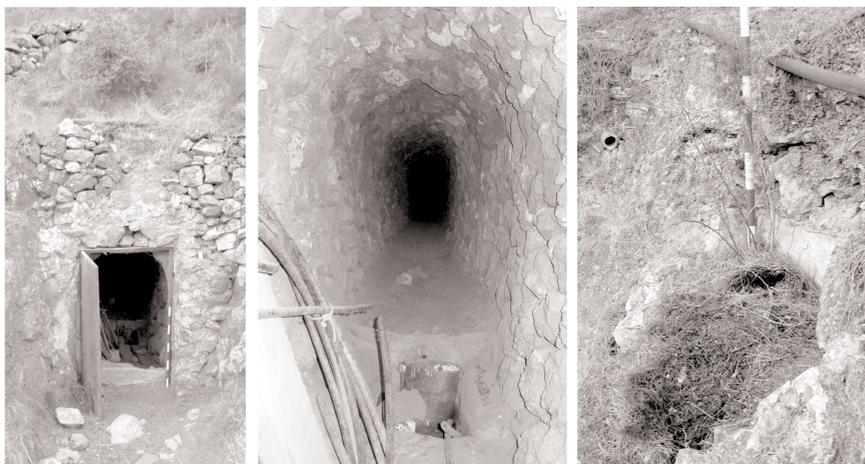
Figura 5. Izquierda y centro: bocamina e interior de la galería de las Aguas del Buitre. A la derecha, canalizaciones para la distribución de las Aguas del Buitre. Sección de la tubería cerámica, restos de una arqueta de registro y tubería metálica.
