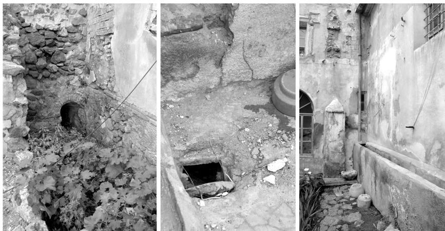
Figura 11. A la izquierda, aliviadero de la balsa intramuros y acequia para riego del huerto. En el centro, detalle de una de las canalizaciones trazadas bajo el suelo del monasterio. A la derecha, canalización para la recogida de aguas de lluvia en el claustro del monasterio.
