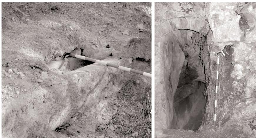
Figura 6. A la izquierda, tramo de canalización visible en el margen derecho del barranco del Sordo. A la derecha, vista de la galería filtrante al pie de la presa de derivación del barranco del Sordo. En la parte superior derecha de la imagen se aprecia la sección de dos canalizaciones que derivarían las aguas subálveas contenidas por la presa.
