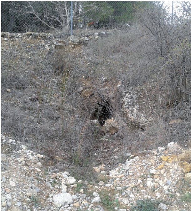
Figura 5. Ejemplo de uno de los antiguos minados, en las inmediaciones de la Fuente de Mula, utilizado antaño para aumentar los caudales.
