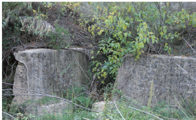
Figura 8. Bocamina de la galería de Ucenda. Con salida directa al cauce del río Mula; tramo protegido por un muro de contención.
