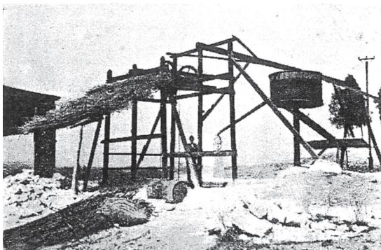
Lámina III. Explotación de yeso, Aljezares.
