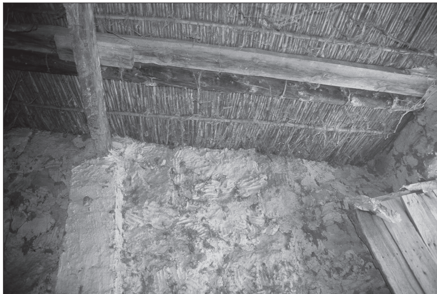
LÁMINA 5. Detalle de la cubierta y la pared de la tená.
