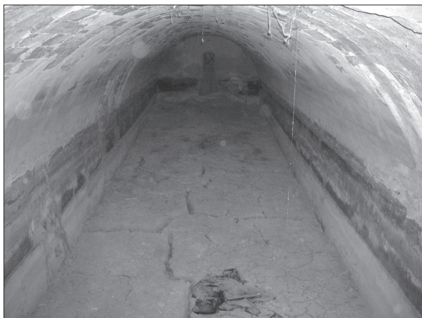
FOTO 12. Interior de un aljibe de bóveda de cañón.
