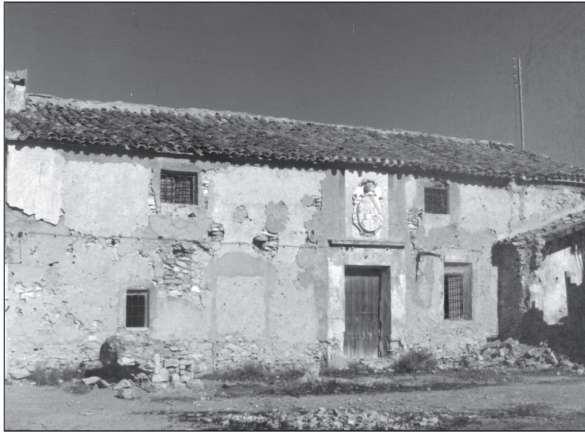
Casa de Pedreño del Jimenado, 1995 antes de su restauración.
