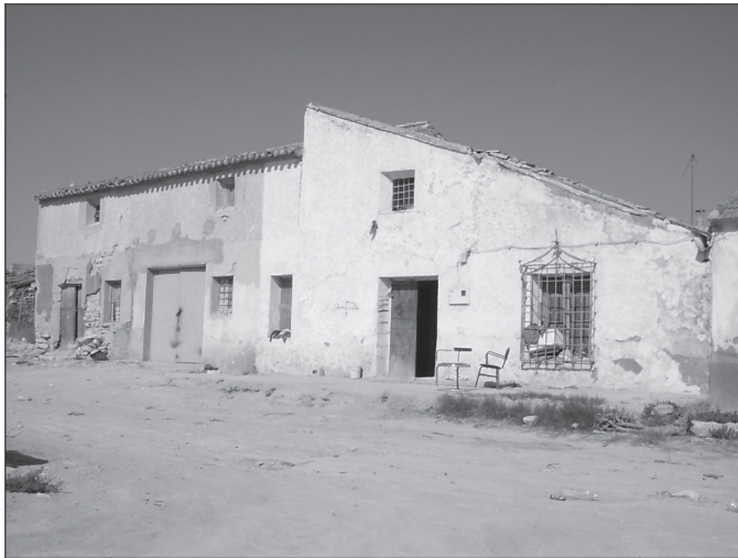
Casa de los Capellanes en la zona de la Rambla honda, muy deteriorada pero se observa la estructura típica de las casas solariegas.
