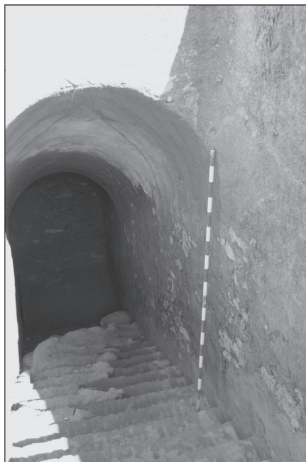
LÁMINA 5: detalle del arranque de la bóveda de cañón. Sector 1A.
