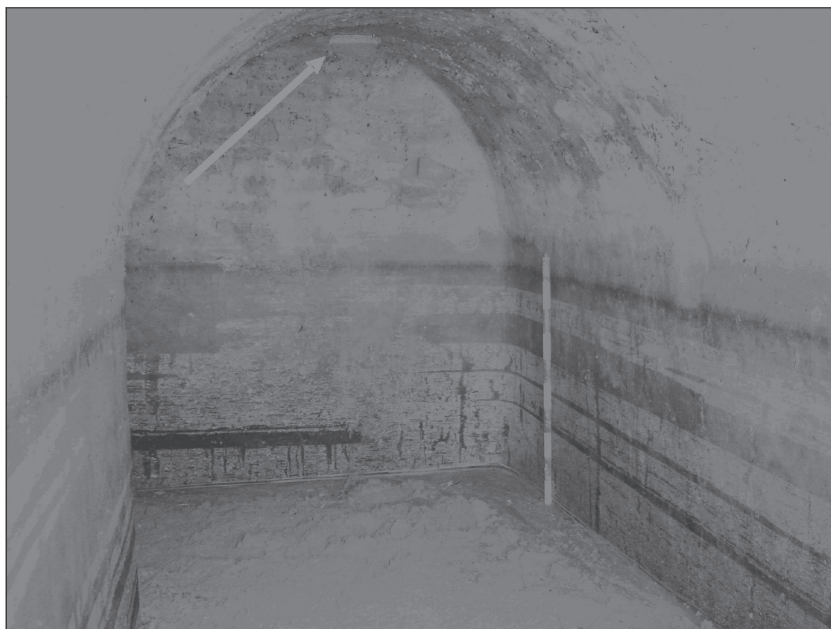
LÁMINA 6: La flecha señala el respiradero. Sector 2A.
