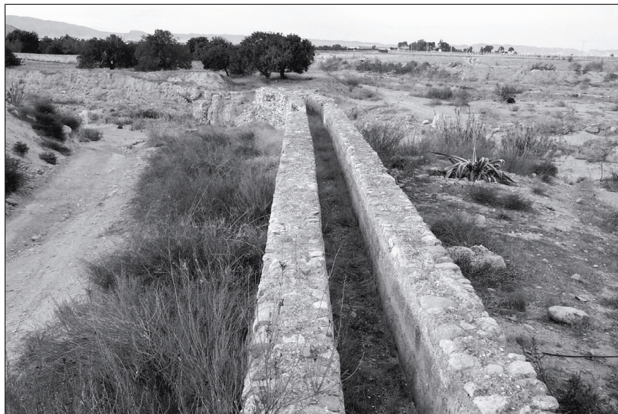
FIGURA 1: Antiguo cauce de Casa Grande hacia Lobosillo. Este cauce quedó inutilizado al romper una avenida el acueducto sobre la rambla del Albuñón.
