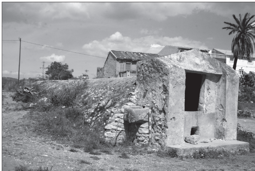
FOTO 5: Aljibe de bóveda de cañón. Casas de Lo León (Corvera).
