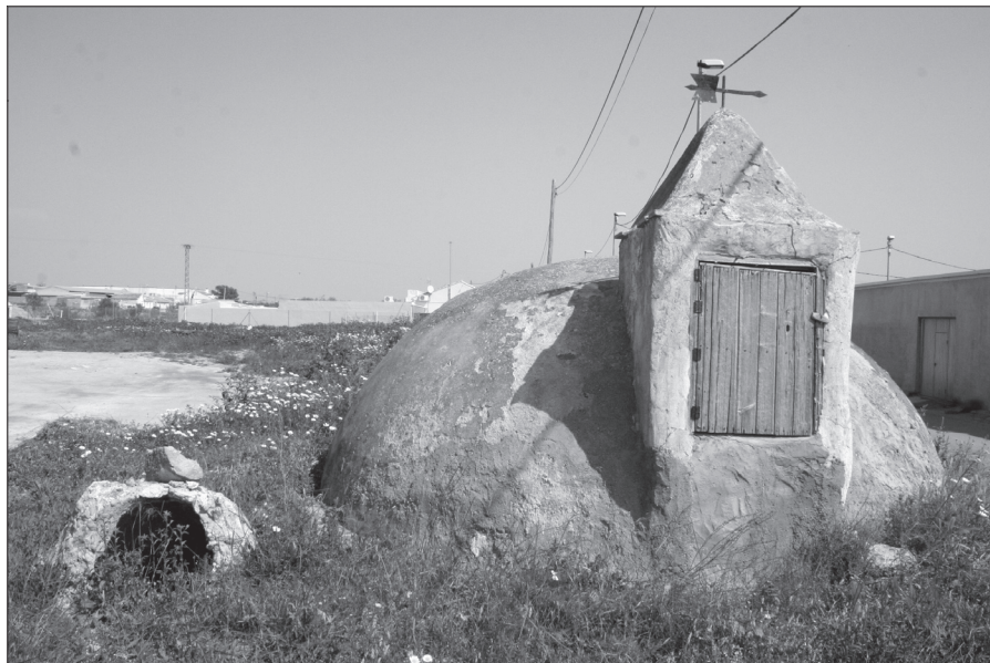
FOTO 4: Aljibe y decantador de cúpula. Los Almagros (Fuente-Álamo).
