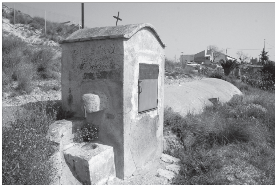
FOTO 9: Cantarero del aljibe del sífon. La Murta (Corvera).
