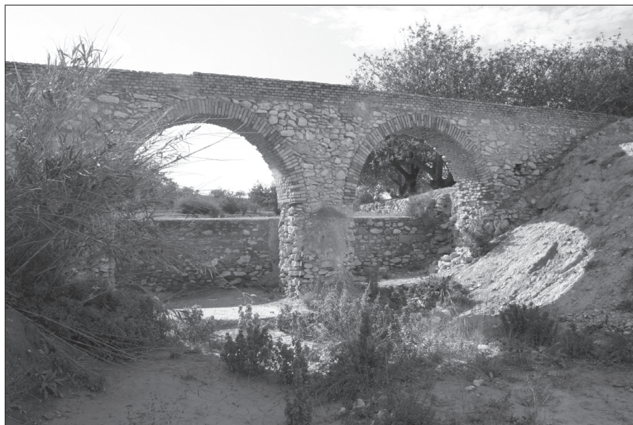
FOTO 17: Acueducto en la Rambla del Fraile. Cartagena.
