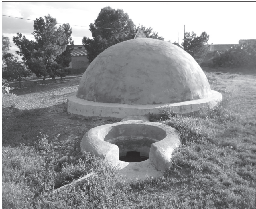
FIGURA 3. En función de la superficie drenada por los canales que concentran y conducen las escorrentías hasta el aljibe, la poza de decantación de los sedimentos transportados por el agua se ubicaba en los laterales o detrás del aljibe, como muestra la imagen.
