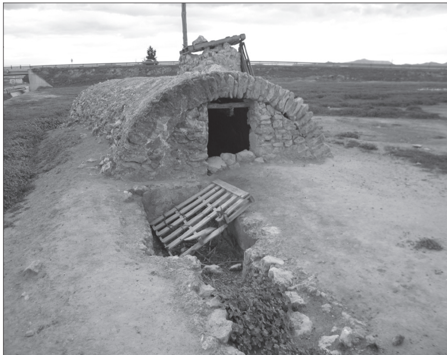
FIGURA 4. El abandono de la población rural ha acarreado también el abandono de las prácticas de conservación de los aljibes y otros sistemas de captación de agua tales como el sistema de boqueras, minas, «lumbreiras» y cultivo en cañada. En la imagen, aljibe bastante deteriorado junto a la carretera de Los Almagros y El Escobar a Fuente Álamo.
