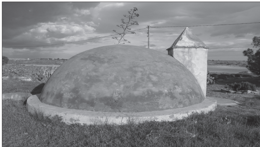
FIGURA 12. Revestimiento externo (restaurado). El Escobar.
