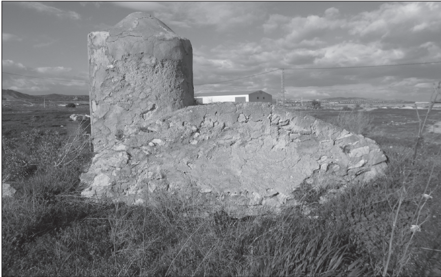
FIGURA 14. Brocal redondo sobre aljibe saliente (infrecuente). La Murta-El Escobar.
