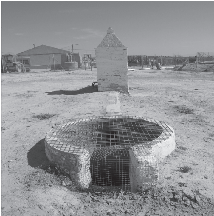
FIGURA 15. Poceta de decantación. Casa Nuevas.
