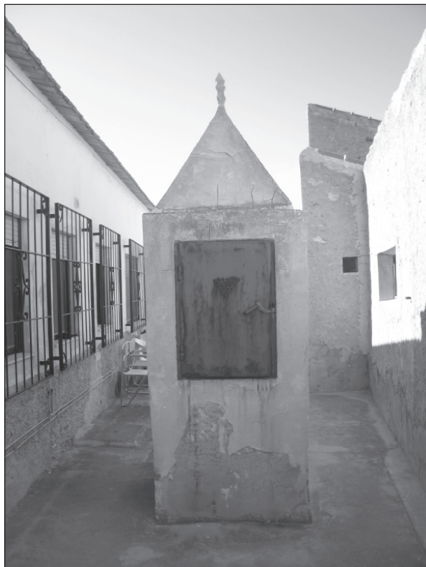
FIGURA 1. Tipo de aljibe común en las casas de núcleos de población rural. Las canales que recogían el agua de los tejados y la conducían al aljibe, por la parte posterior han desaparecido. En la imagen construcción localizada en la «costera de la Sierra de Carrascoy».
