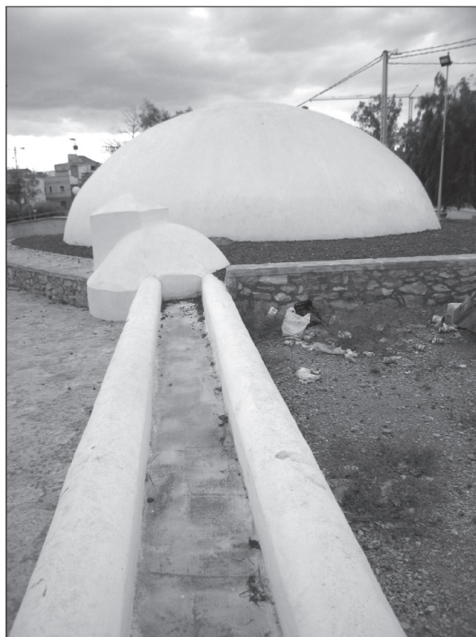
FIGURA 17. Canaleta y su acometida a la arqueta de decantación (hoy ciega). Casa del Agua. Fuente Álamo.
