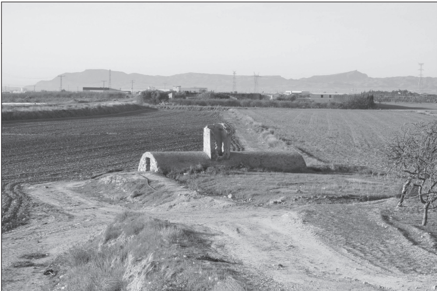
LÁMINA 5: Aljibe de bóveda de cañón de las Casas del Alto (El Jimenado).
