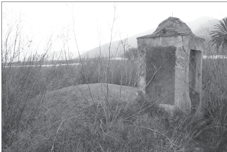
LÁMINA 1: Aljibe 2 Casa de la Balsa (San Cayetano).
