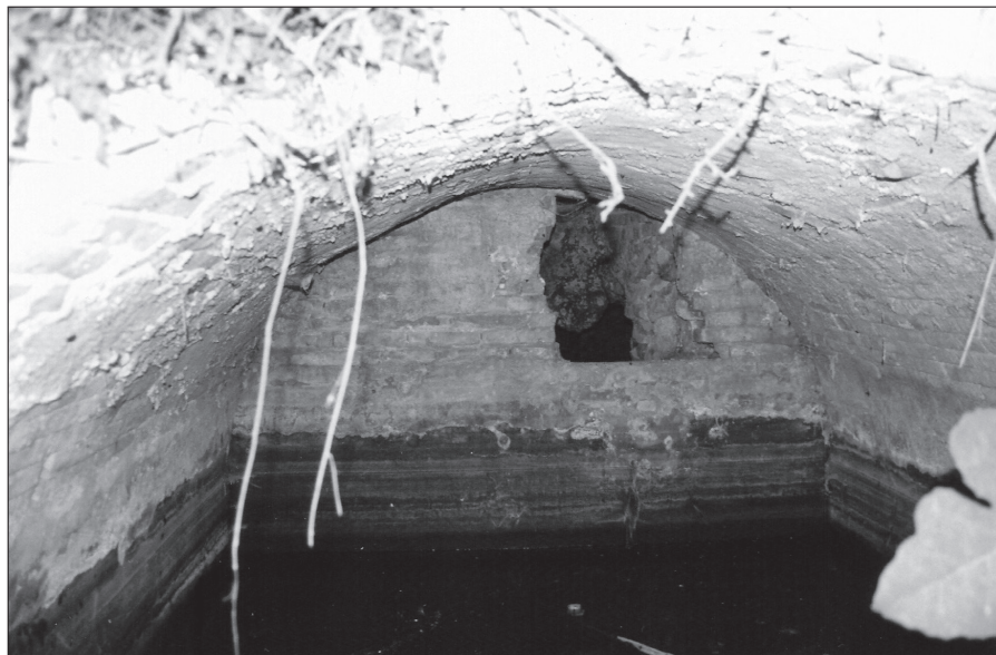
FIGURA 10: Depósito de agua en la que se almacenan en un primer momento las aguas procedentes del manantial del Barranco del Feo (Barranco de Pedro Pardo o de Mendoza). Cartagena.
