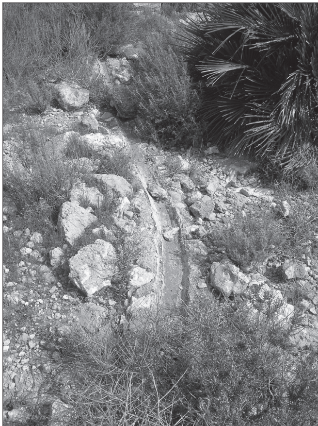
FIGURA 5: Canalización que conduce las aguas del manantial de San Natalio. Coto de San Juan. Cartagena.
