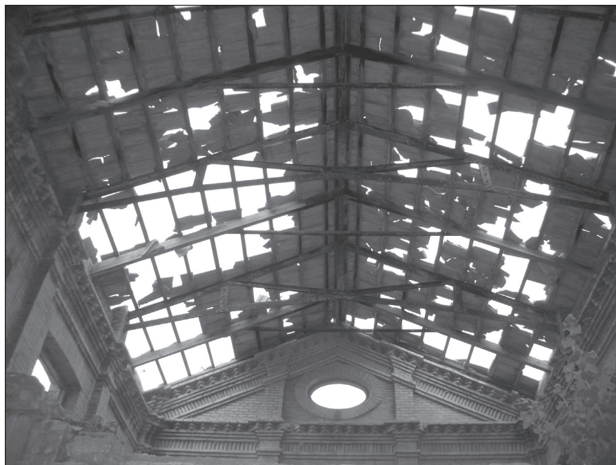
FIGURA 6: Vista interna de la cubierta del depósito n° 1 en Canteras (Cartagena).
