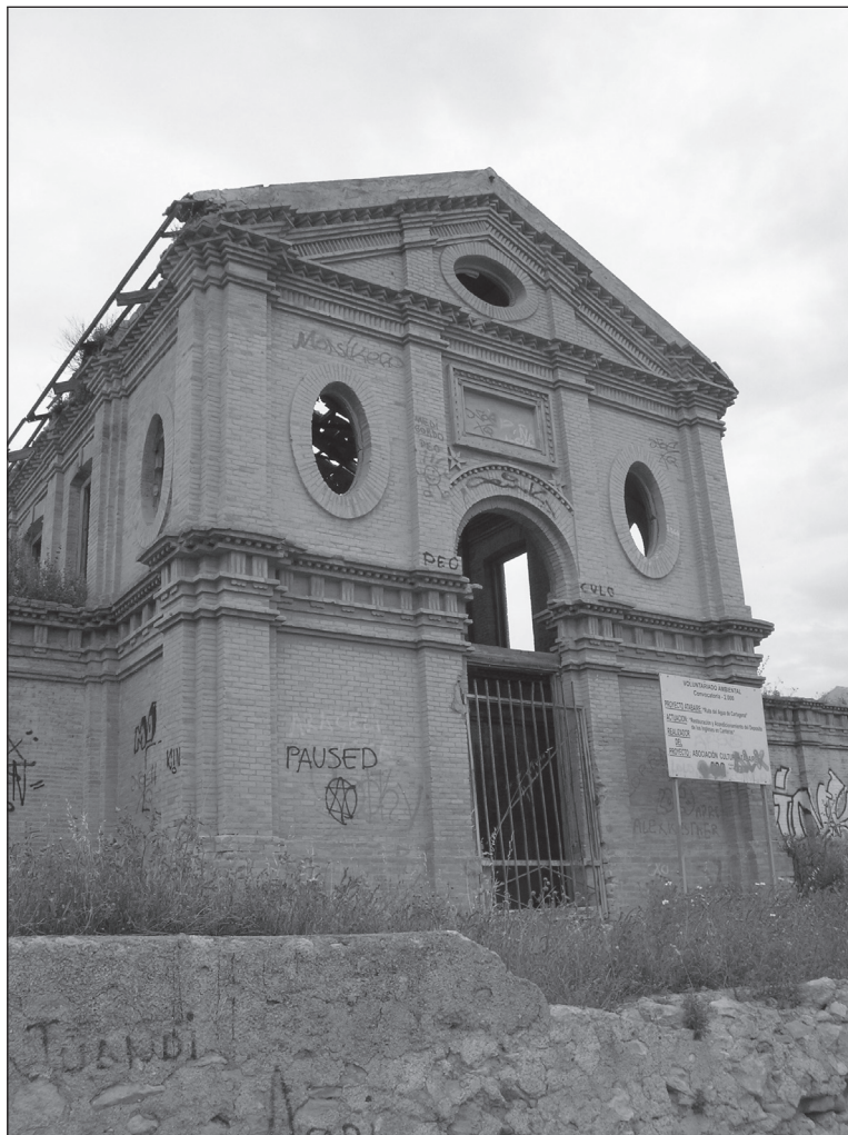
FIGURA 7: Detalle de la fachada del depósito n° 1 en Canteras (Cartagena).
