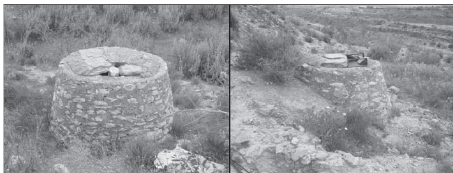
FOTO n° 15: Lumbreras del Sistema de Corverica.
