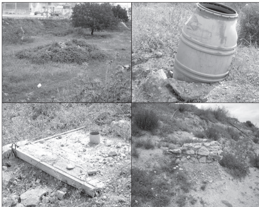
FOTO n° 6: Lumbreras de las galerías que abastecían de agua la localidad de Fuente Álamo.
