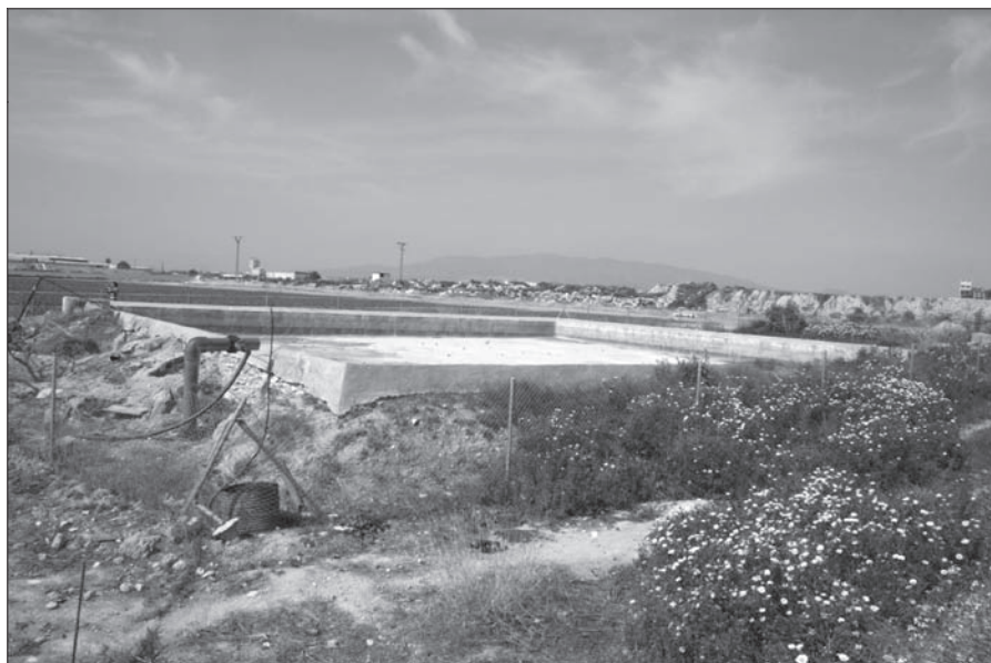
FOTO n° 4: Antigua balsa para recibir las aguas alumbradas de un pozo vertical.
