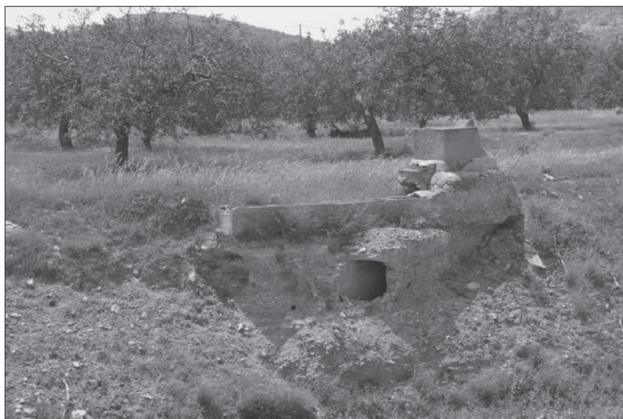
FOTO nº 10: Abrevadero, lumbrera y galería que manifiesta las necesidades de riego y abastecimiento de estas poblaciones.
