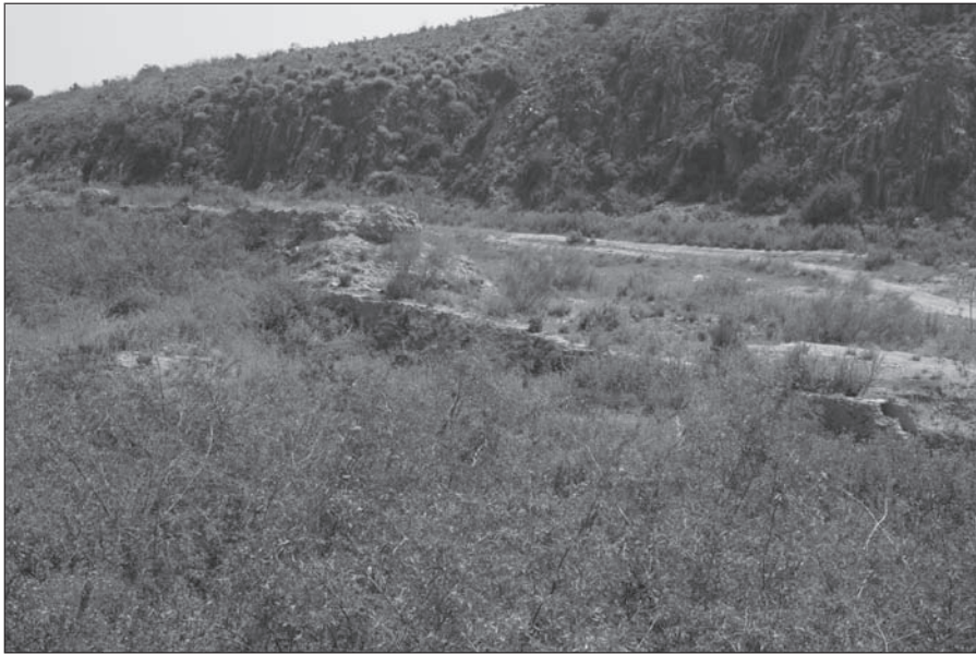
FOTO nº 3: Galería con lumbreras construida en los sedimentos de la Rambla de Fuente Álamo.
