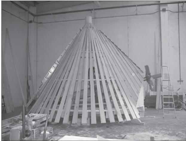
M.- **Palo Guía.** Este palo es de madera de unos 30 cms de diámetro por 14m de longitud. Está debidamente reforzado con pletinas y zunchos metálicos.
