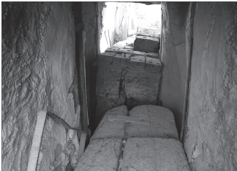
FOTO 7. Detalle del interior de la capilla con la cabeza de ambas vigas entre las cárceles o guideras.
