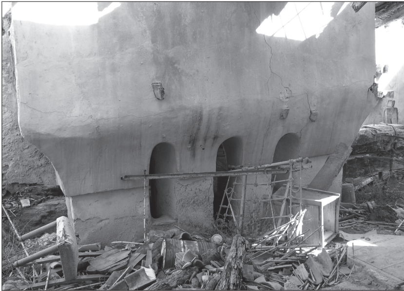
FOTO 3. Vista frontal de la torre contrapeso: arriba el cuerpo prismático macizo o castillete y debajo la capilla, con la entrada en la parte central y las ventanas a los lados.
