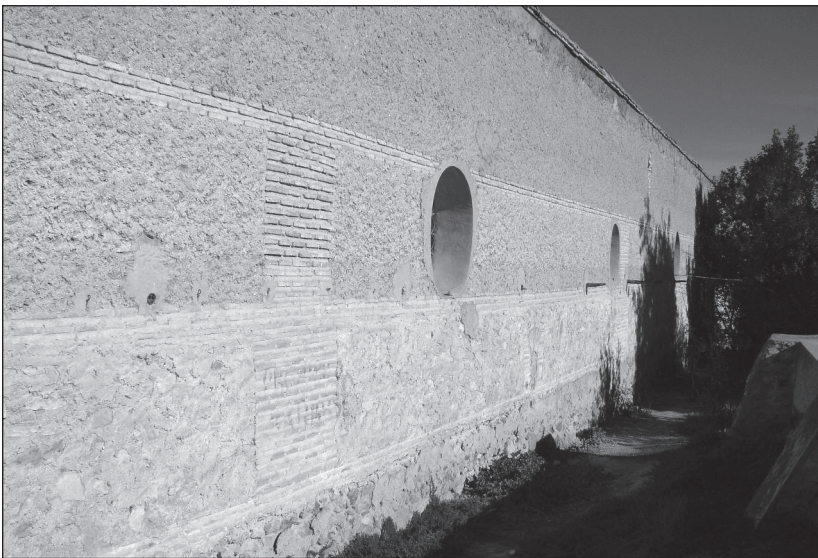
FOTO 8. Aspecto de la fábrica de los paramentos de la posada (ala meridional). Zócalo de mampostería sobre el que se alzan pilares de ladrillo que delimitan cajas de mampostería entre verdugadas de ladrillo.
