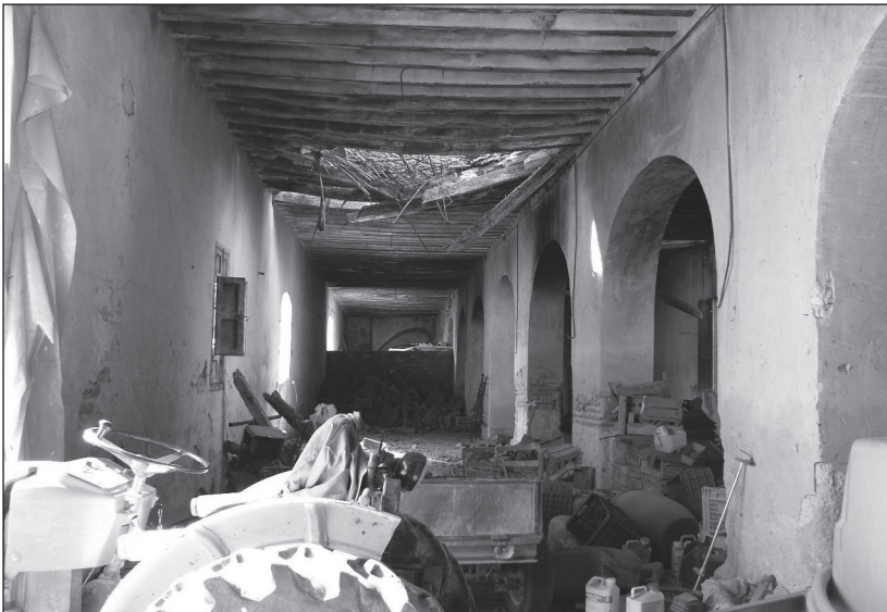
FOTO 4. Estado actual de la nave principal dividida por un muro de carga central con arcos de medio punto.
