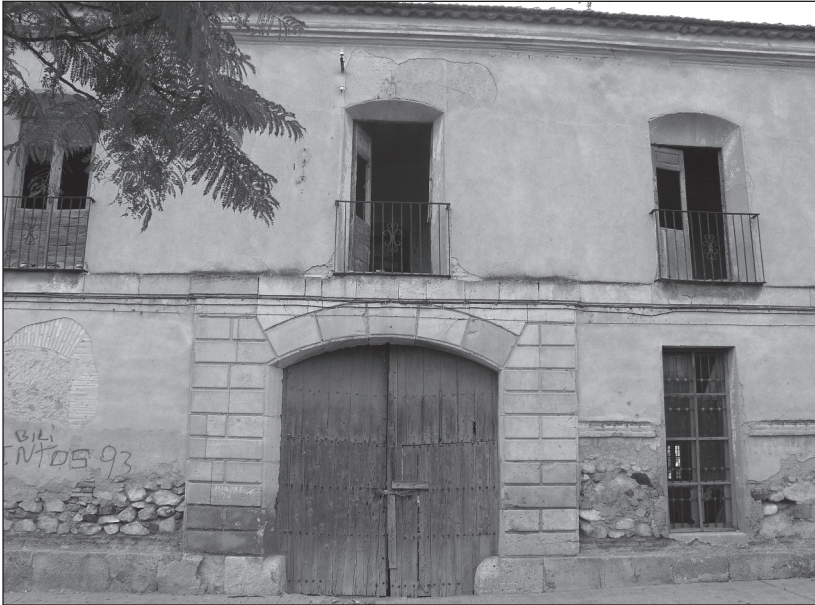
FOTO 3. Portada de carruajes oriental con fábrica sillería de cantería con suave almohadillado. Presenta defensas en la base y esviaje de las jambas.
