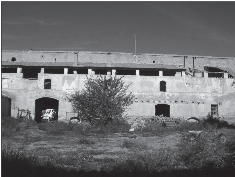
FOTO 5. Fachada interior del patio del cuerpo principal de la posada.
