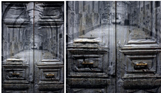
Figura 9. Daños ocasionados por parámetros ambientales extremos.
