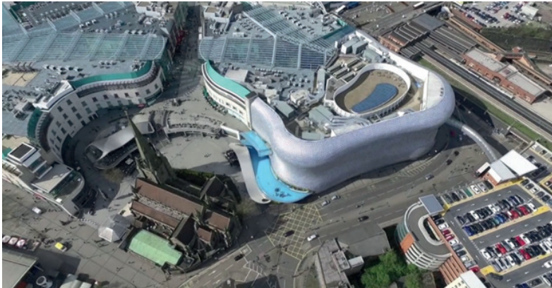
Figura 3. Vista aérea del Bull Ring en la que se observan las conexiones peatonales creadas con la Iglesia de San Martín (abajo) y el Mercado de la ciudad (a la izquierda de la iglesia). Fuente: www.youtube.com/watch?v=teVqi_fQs4w
