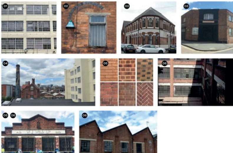
Figura 16. Detalles arquitectónicos del Digbeth: fachadas enrejadas con distribución regular de ventanas (1), elementos transformados (2), chaflanes (3), agregaciones y recursos y soluciones características de la arquitectura industrial en fachadas, cerramientos y cubiertas (4), uso generalizado de ladrillo rojo y negro (5), elementos arquitectónicos expresivos, tales como dinteles, parapetos y señalética (6), y líneas de tejado variadas y articuladas (7). Fuente: Turley, 2019.
