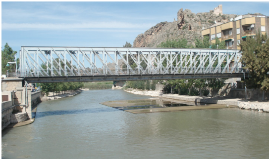
Figura 2. Puente de Hierro. Blanca, Murcia, 2010. Fotografía del autor.
