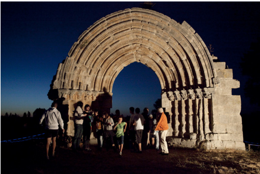
Figura 1. Arco de San Miguel de Mazarreros el día de la intervención. (Autor: Daniel Tomás Marquina)
