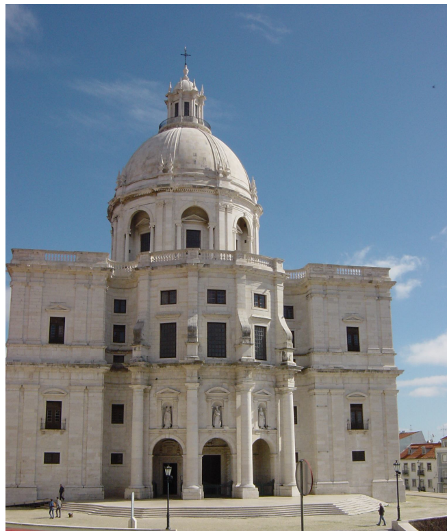
Figura 3: Iglesia de Santa Engrácia. Lisboa. Por el arquitecto João Antunes hacia 1680, encargo de D. Pedro II de Portugal.
