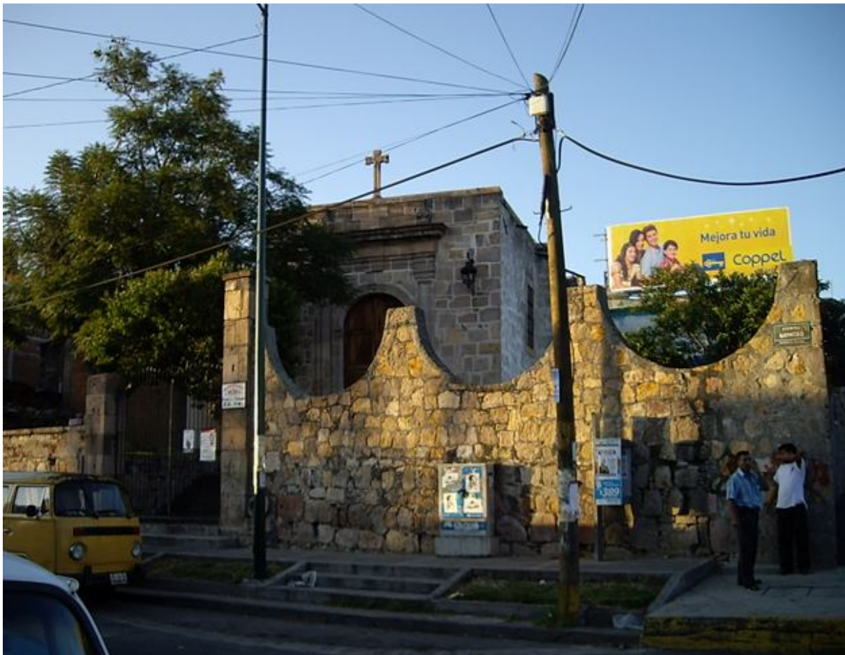
Figura 3: Vista de la capilla de Santiaguito, como se puede observar, ningún tipo de consideración patrimonial se otorga a esta antigua edificación.
