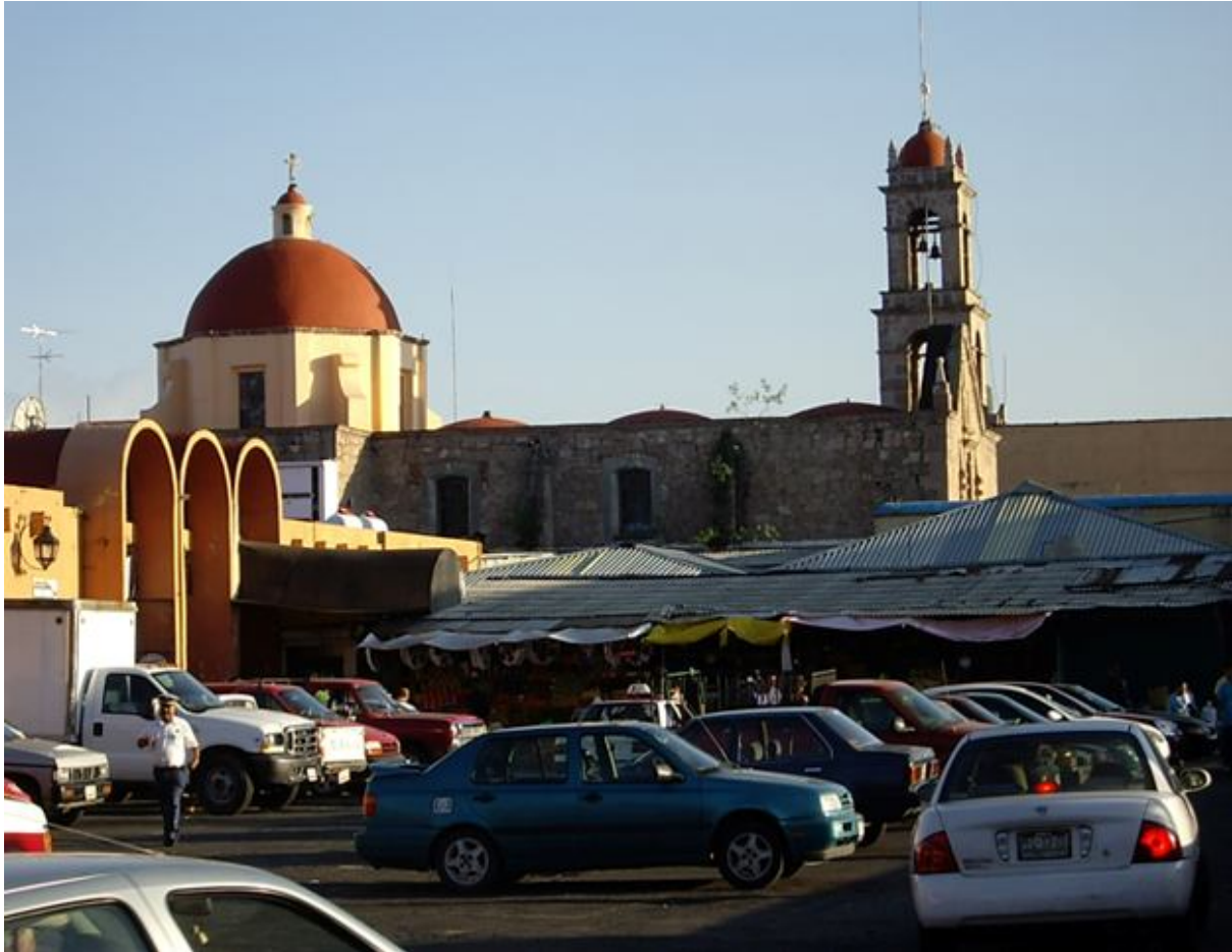
Figura 2: Vista de la iglesia de San Juan Bautista de los Mexicanos desde su costado norte, la saturación comercial y vehicular abruma el núcleo de este antiguo barrio, a pesar de encontrarse dentro del polígono preservado.
