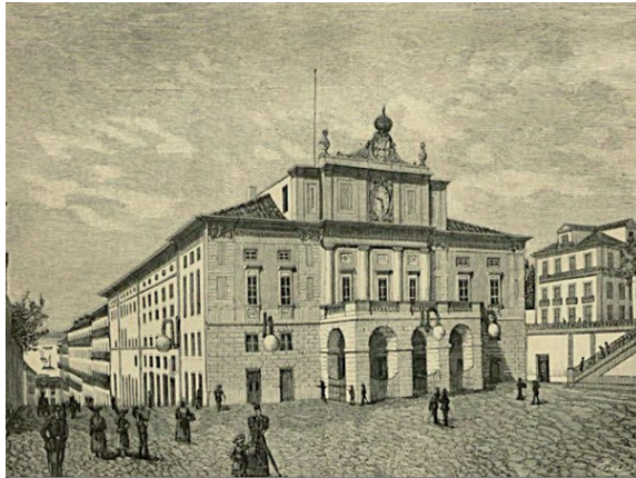
Teatro Nacional de San Carlos. Lisboa. Fachada principal. Restos de colección.
