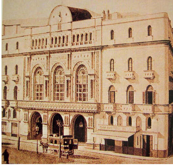
Gran Teatro del Liceo de Barcelona. Fachada Principal. Observatorio de Espacios Escénicos.
