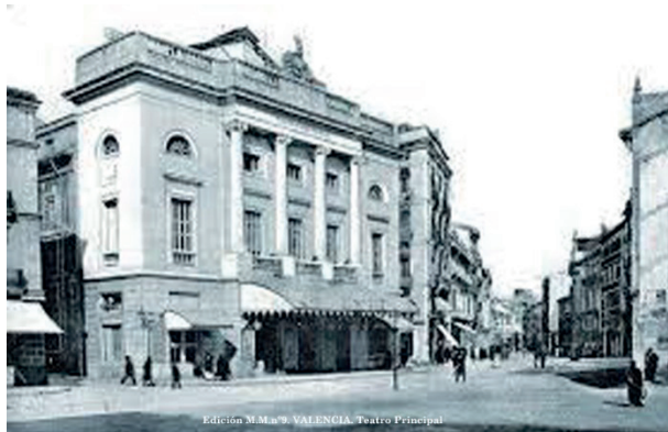
Teatro Principal de Valencia. Fachada principal. Edición M.M. n°9.
