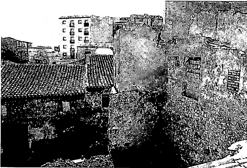
Lámina 2.2 Torre de la calle Rambla.
