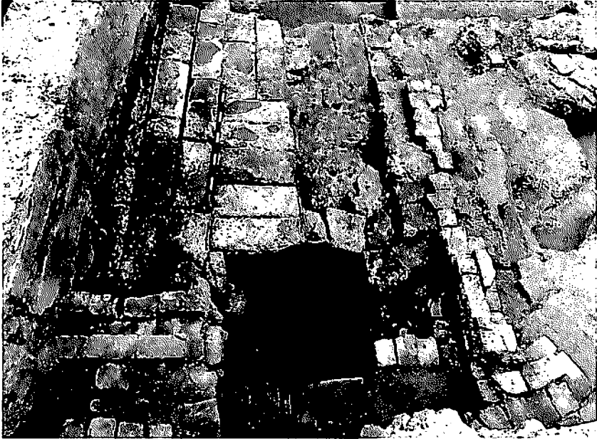
6.- Sala oeste. Pavimentación original y remodelación (espacio 6.2).
