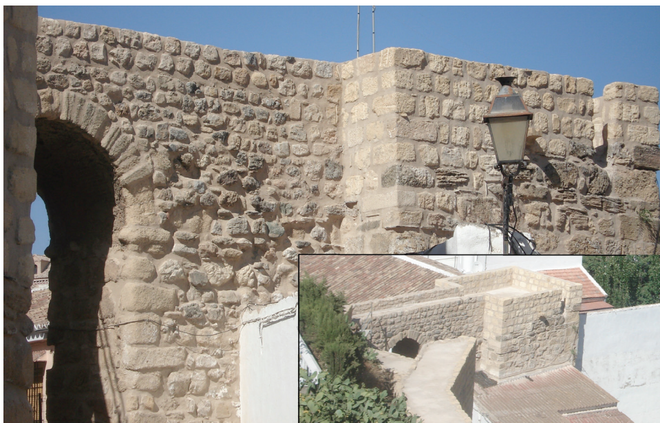
Figura 2. Torre albarrana Puerta del Agua perteneciente al complejo de la coracha.
