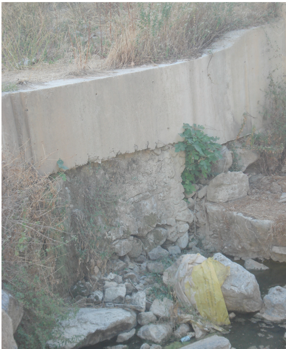
Figura 6. Presa sobre el río de la Villa.
