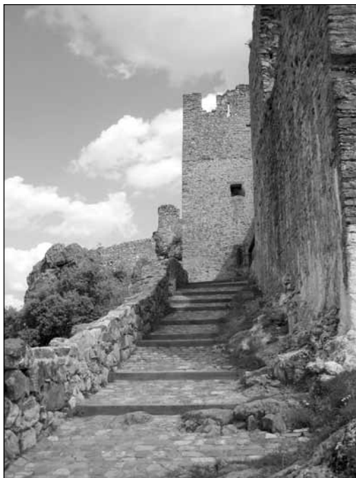
FIGURA 3 Área 1. Rampa de acceso.
