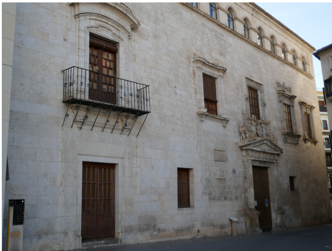
Figura 1. Fachada del edificio
