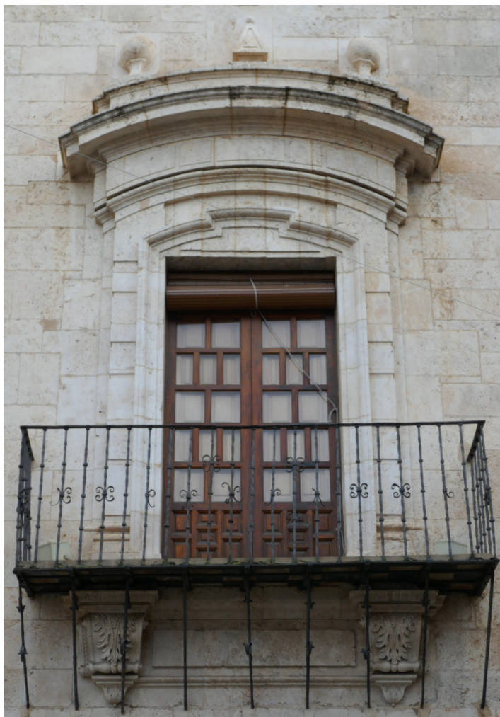
Figura 5. Ventana-balcón más septentrional de la fachada
