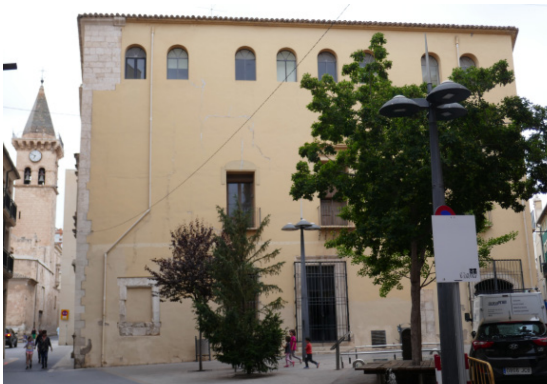
Figura 8. La Fachada Meridional
