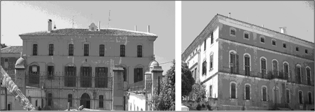
Fig. 8. Fachadas Sur y Norte.
