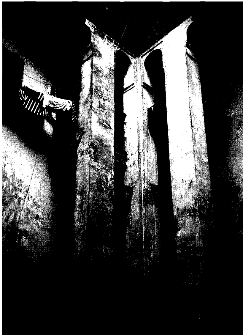
Figura 6. Columnas-pilares que sustentan el alerón superior. Interior del patio. Darb Al-Nuala
