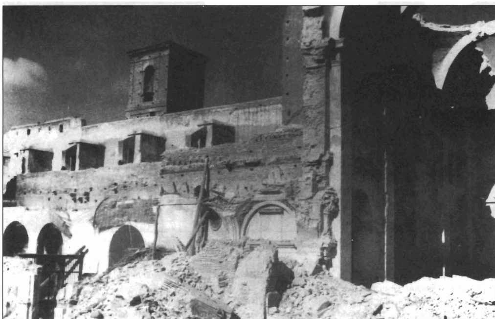
Figura 10. Aspecto de las capillas del lado derecho de la Iglesia Mayor de Motril tras la explosión de 1938.
