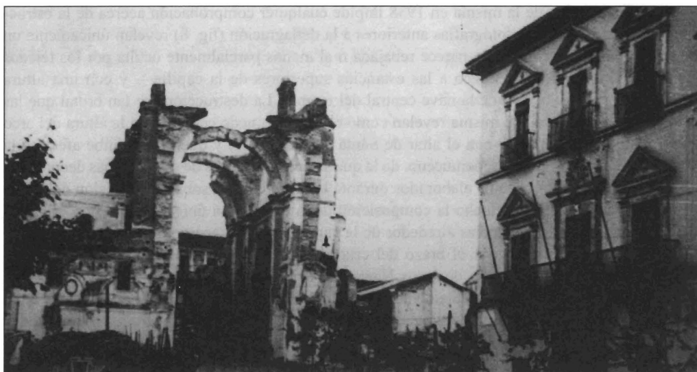
Figura 9. Aspecto del lado derecho del crucero de la Iglesia Mayor de Motril tras la explosión de 1938.
