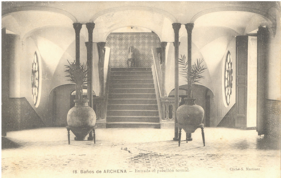
Fig. 5. Entrada al pabellón termal. Hacia 1900. Archivo del Balneario de Archena.
