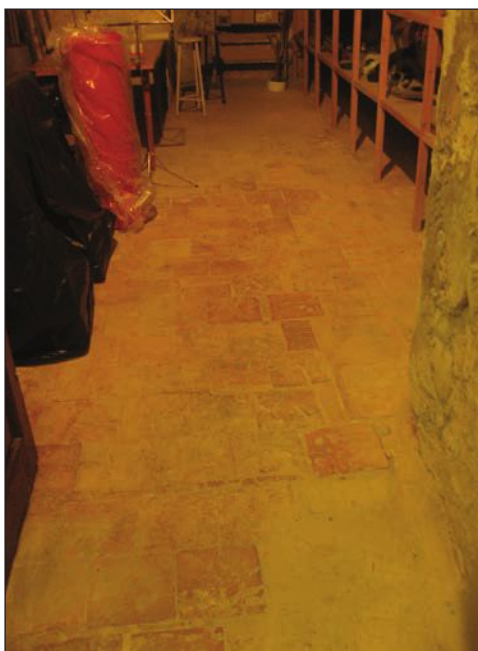
Fig.3 Detalle del pavimento original
