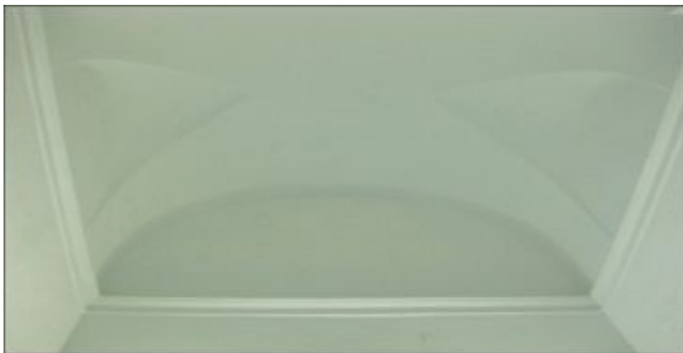
Fig.6 Capilla de la Comunión. Detalle de la bóveda
